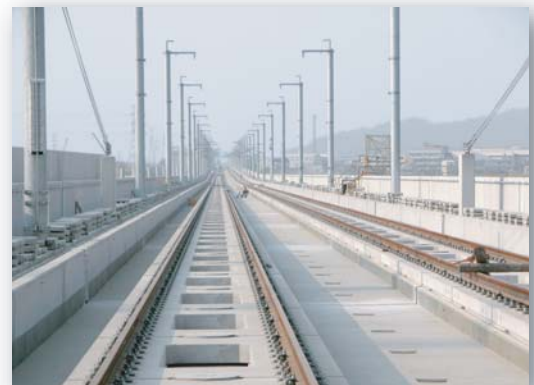
Einrichtung der festen Fahrbahn, Korea
