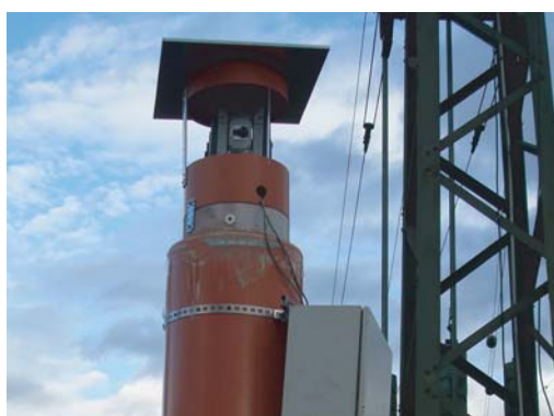
Automatisch messender Tachymeter auf Messpfiler, Überwachung eines Gleisfeldes, Aachkanal/Singen
