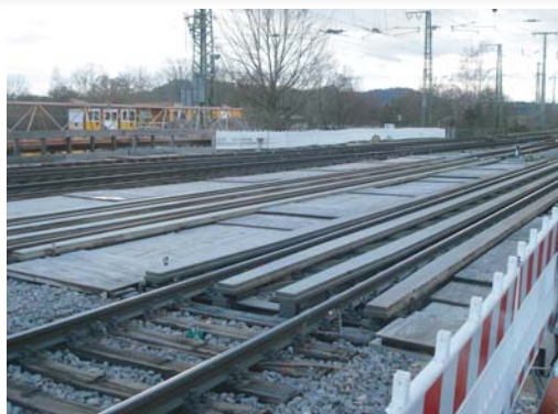
Überwachung von 2 Hilfsbrücken und einer Weichensonderkonstruktion, Aachkanal/Singen
